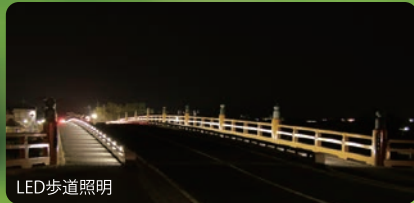
LED歩道照明
